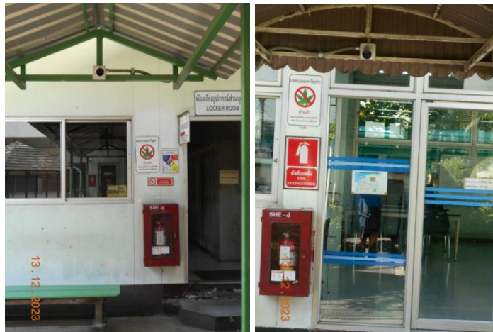
รูปที่ 1.16-5 ภาพติดตั้งกล้อง CCTV เพิ่มจำนวน 2 ตัวที่บริเวณทางออกของประตูออฟฟิศ
