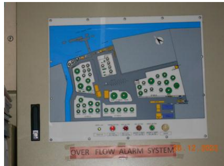
รูปที่ 1.16-9 ติดตั้งระบบสัญญาณ Overflow ของ TA.109
