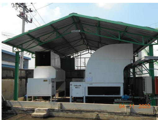
รูปที่ 2.4-3 เครื่องทำความเย็น (Chiller)
