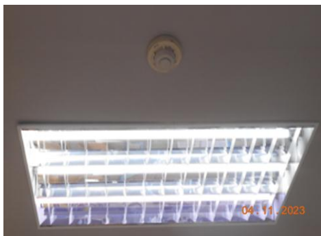
รูปที่ 2.5.3-3 เครื่องตรวจจับความร้อน (Heat detector) ฝ้าที่เพดานของสำนักงาน
