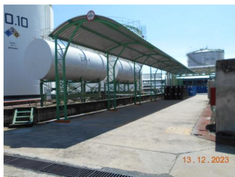
รูปที่ 1.16-3 ติดตั้งโครงหลังคาเก็บถังชั่วคราวที่บริเวณ Area-D
