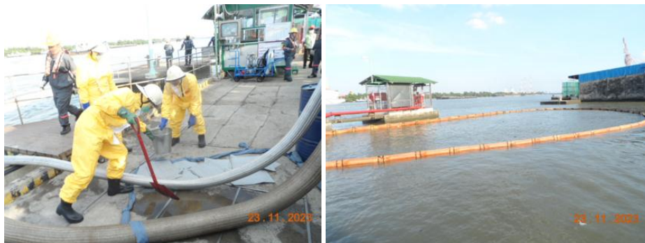
รูปที่ 2.1-6 การซ้อมแผนปฏิบัติงานกรณีรั่วไหลของน้ำมันจากเรือลงสู่แม่น้ำ (แม่น้ำเจ้าพระยา) ขณะเรือเทียบท่า โดยใช้ Oil Fence ซึ่งเป็นทุ่นลอย และมีแผ่นผ้าใบรวมมีความยาว 100 เมตร โดยประมาณ ปิดล้อมสกัดกั้นไม่ให้คราบน้ำมันแพร่กระจายออกไป พร้อมทั้งติดตั้งตัวโรย Boom จำนวน 2 ตัวที่หน้าท่า
