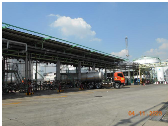
รูปที่ 1.8.7-1 สถานีสูบน้ำเคมีภัณฑ์ลงรถแท้งก์ (Lorry Station)
