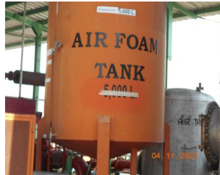
รูปที่ 2.5.3-4 ถังแอร์โฟมดับเพลิงภายในโครงการ
