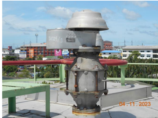
รูปที่ 2.4-1 ระบบควบคุมการระบายอากาศเข้า-ออก ภายในถังโดยติดตั้ง Automatic Breather Valve ซึ่งทำหน้าที่ปรับความดันภายในถังและนอกถังให้อยู่ในสถานะสมดุล
