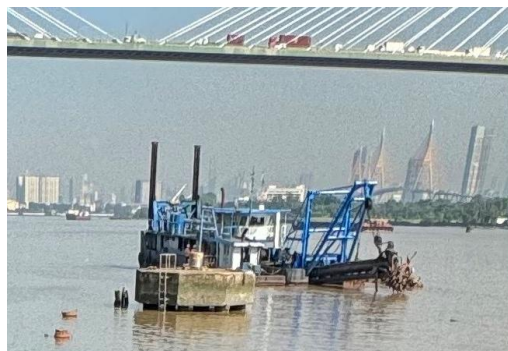
รูปที่ 1.16-7 ภาพดำเนินการขุดลอกบริเวณหน้าท่าเรือ BKK11
