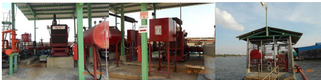
รูปที่ 1.8.10-1 เครื่องสูบน้ำเครื่องที่ 1, 2 และ 3 ตามลำดับ (Fire Pump)
