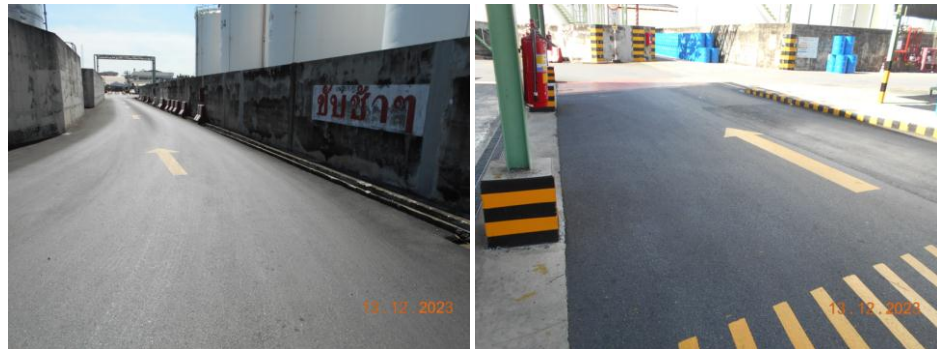
รูปที่ 1.16-6 ภาพการถมถนนลาดยางบริเวณเส้นทางเดินออกของรถ
