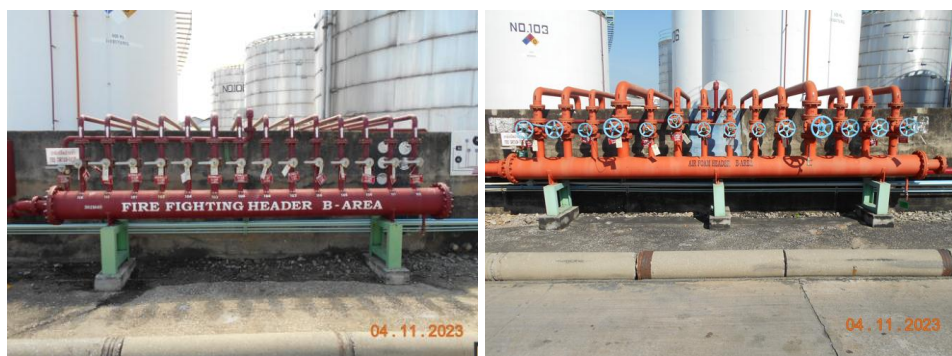
รูปที่ 1.8.3-9 (ซ้าย) ท่อดับเพลิง และ (ขวา) Air foam Header Zone 4 : B- Area
