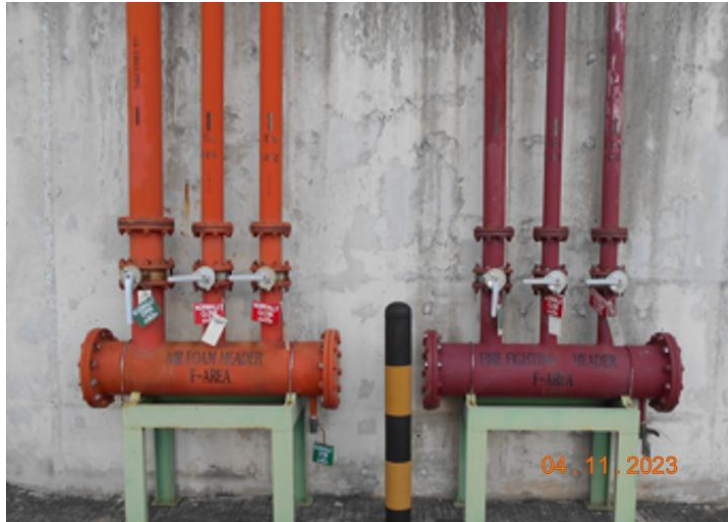
รูปที่ 1.8.3-15 ท่อดับเพลิง และ Air foam Header Zone 7 : F-Area
