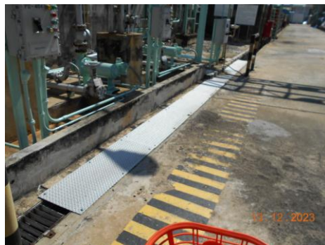
รูปที่ 1.16-2 ภาพซ่อมแซมรางระบายน้ำที่บริเวณ Area-E
