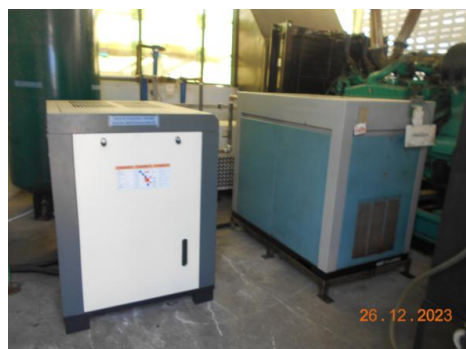
รูปที่ 1.16-11 ติดตั้ง Air compressor (60 HP) ตัวใหม่
